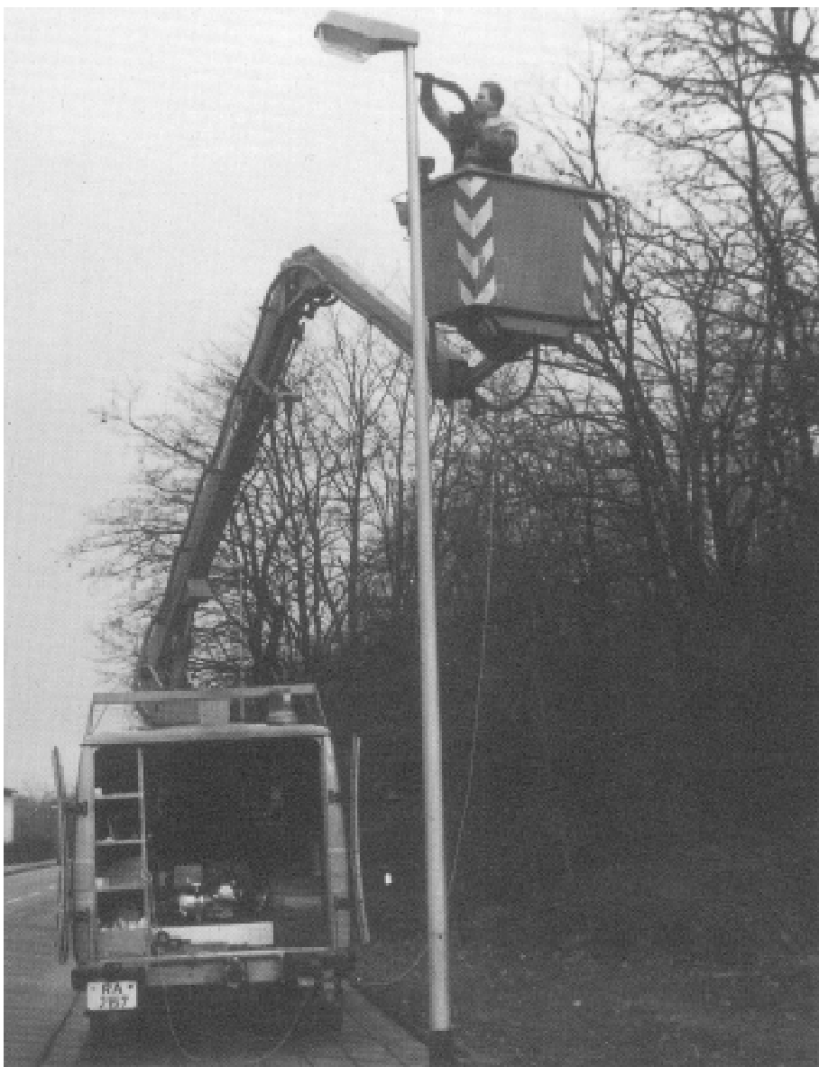
Foto 3: Anstatt mit Hubsteigern und Staubsaugern den Eigelegen des Schwammspinners zu Leibe zu rücken, sollten besser die Quecksilbergegen Natriumdampf-Lampen ausgetauscht werden.
