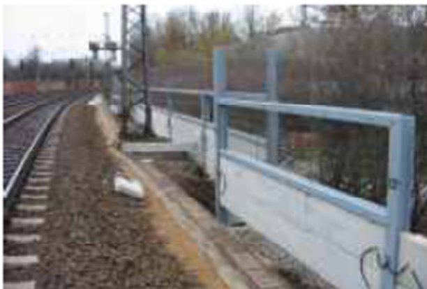
Foto 2: Lärmschutzwand mit Glaselementen
