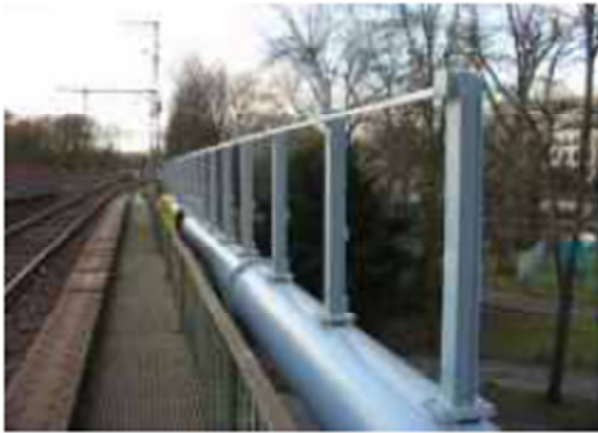
Foto 1: Lärmschutzwand auf Brücke
