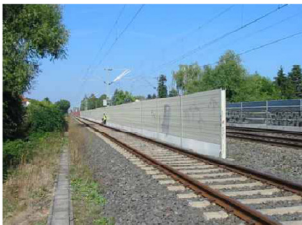
Foto 3: Lärmschutzwand zwischen zwei Strecken
