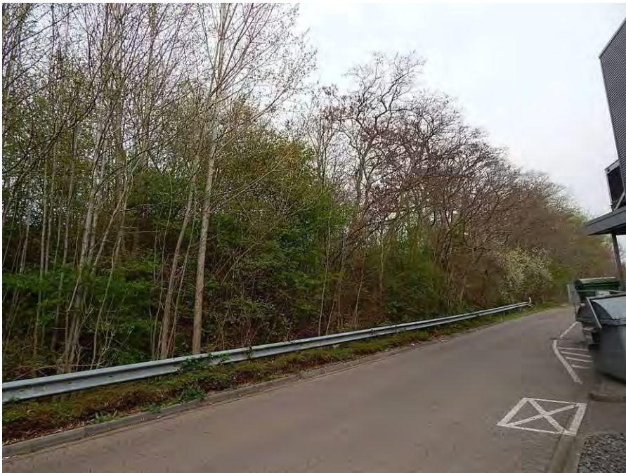
Abb. 25 Südseite von Abschnitt 2.
