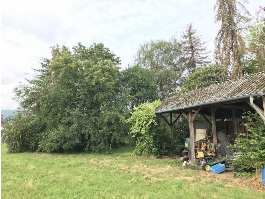
Abb. 7: Remise im Plangebiet;
