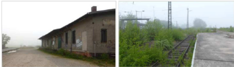
Abb. 2: Vorhandene Strukturen innerhalb der Planfläche
