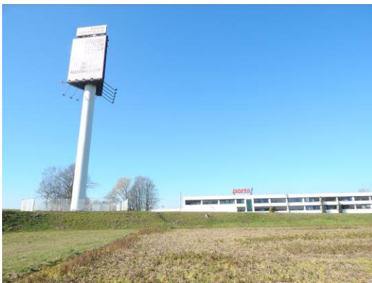
Abb. 9 Blick auf den Werbemast im Südwesten des Plangebietes.
