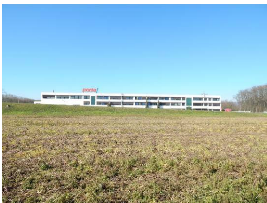
Abb. 30 Blick auf das bestehende Betriebsgebäude aus Richtung Südosten über das Plangebiet.
