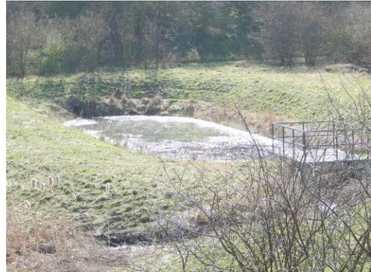
Abb. 24 Regenrückhaltebecken ohne Röhrichtbestand südlich des Plangebietes.
