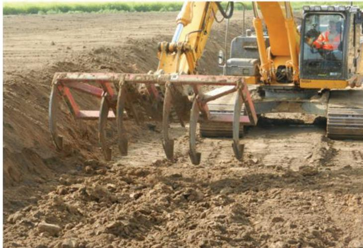
Abbildung 8: Lockerung mittels Tiefengrubber am Bagger (© Gerhard Dumbeck, Quelle: [5])
