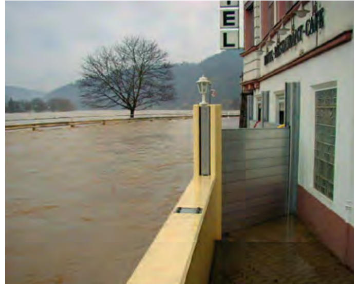
Umlaufender Hochwasserschutz mit teilmobilen Schutzelementen
