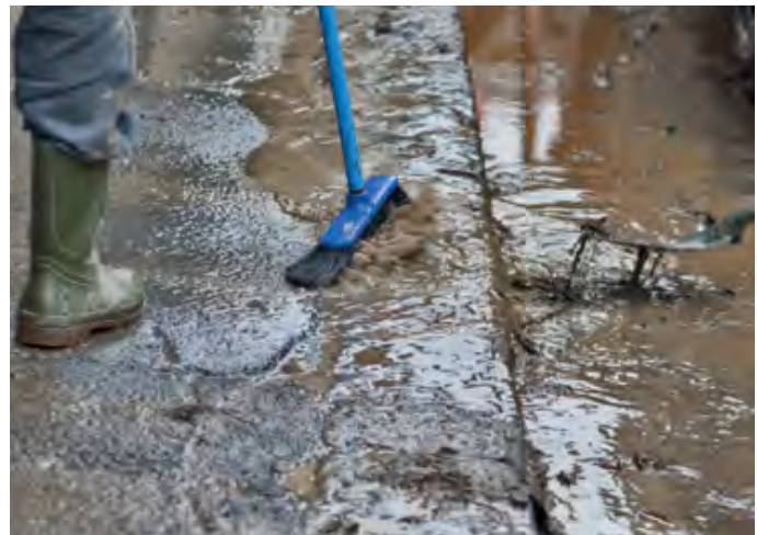
Schlamm-beseitigung mit abfließendem Hochwasser
