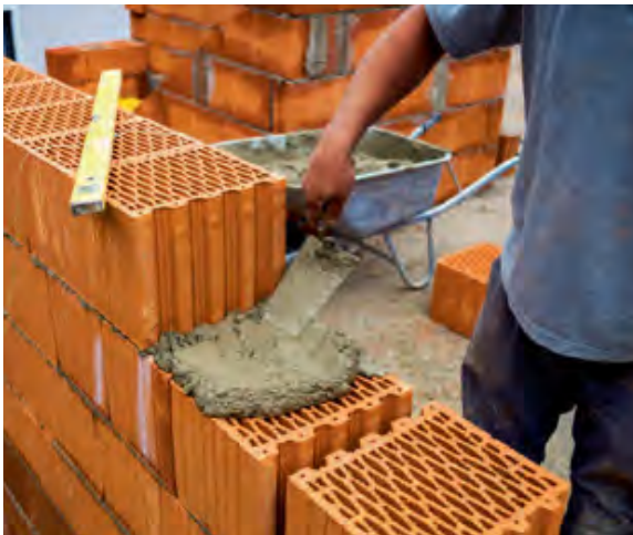
Mauerwerk aus Hochlochziegeln mit geringer Rohdichte
