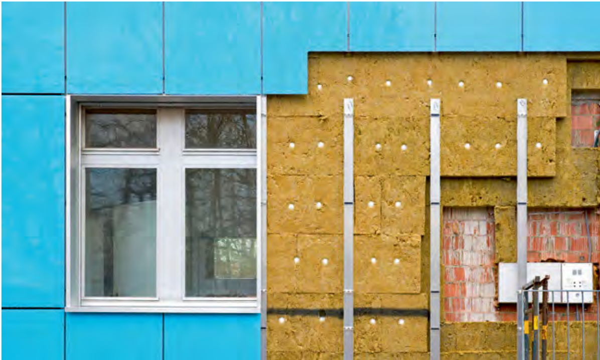
Hinterlüftete Fassadenkonstruktion
