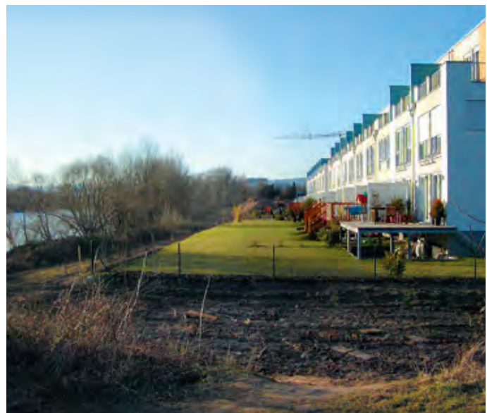
Hochwasserangepasste Bauweise mit erhöhtem Erdgeschoss
