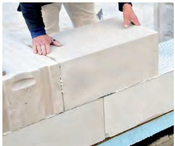
Mauerwerk aus Porenbeton
