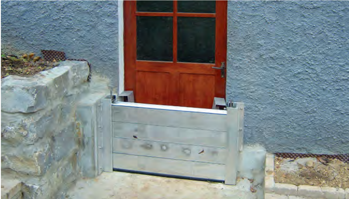
Objektschutz an Gebäudeöffnungen
