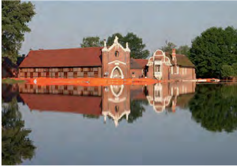
Hochwasserschutz mit mobilem wassergefülltem Schlauchsystem
