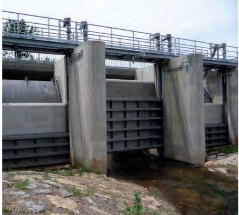
Verschlussbauwerk eines Hochwasserrückhaltebeckens
