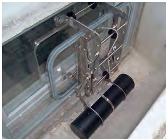
Automatisch schließende Vorsatzscheibe
