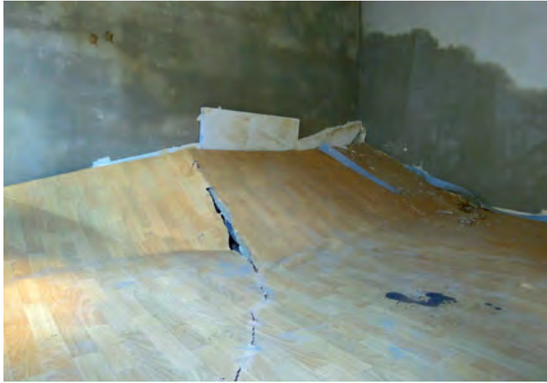
Aufgeschwommene Erdgeschossfußbodenkonstruktion
