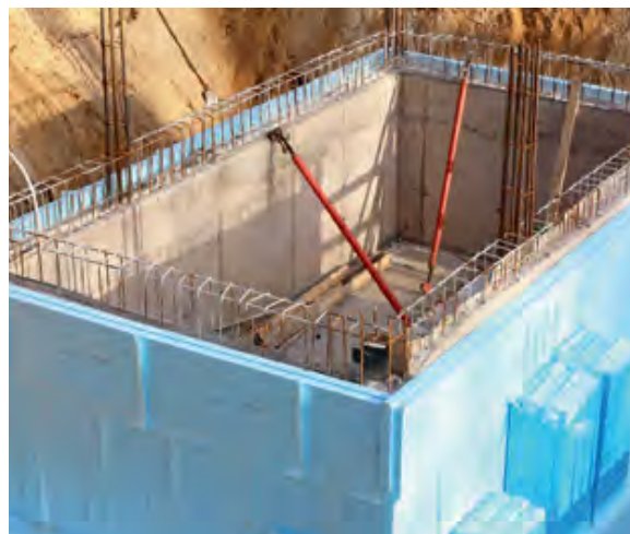
Keller in WU-Bauweise mit Wärmedämmschicht
