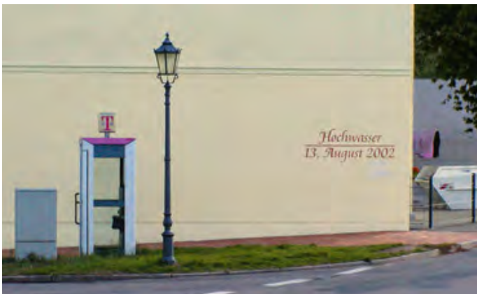
Plakative Hochwassermarke an der Zwickauer Mulde in Colditz
