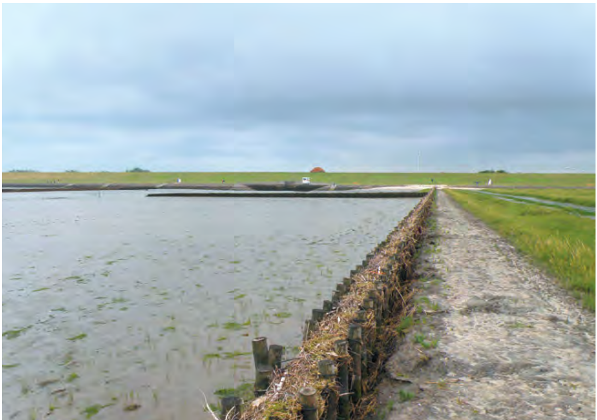
Küstenschutz mit Lahnungen und Hochwasserschutzdeich
