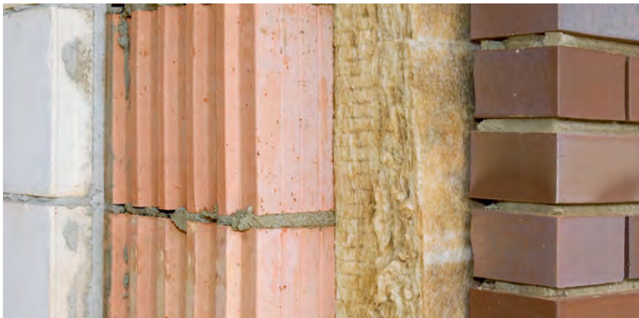
Mehrschalige Außenwandkonstruktion
