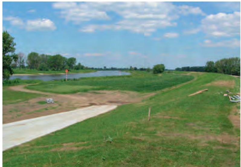
Hochwasserschutzdeich an der Elbe
