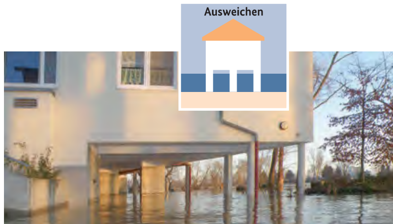
Ausweichen: zum Beispiel durch Aufständern von Gebäuden
