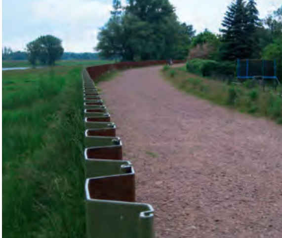
Hochwasserschutzwand mit Stahlspundwand
